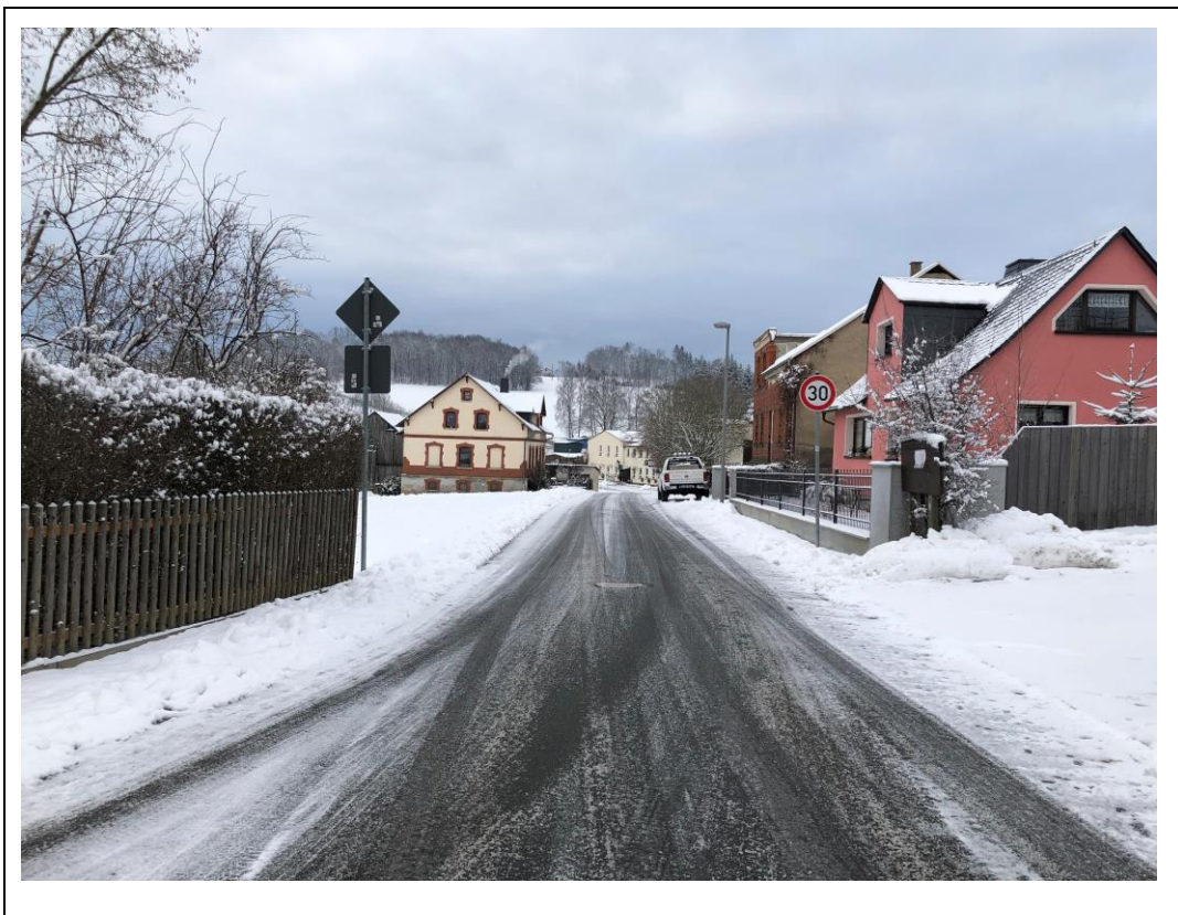
Abb. 9 Foto Ortslage Blickrichtung Südosten
